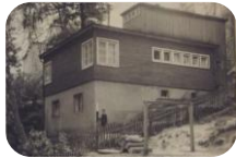
1. ul. Tatrzeńska 7 Obiekt TBO proj. T. Jędrzejewski II poł. lat 30ch.
