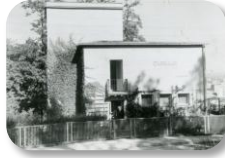
3. Tatrzeńska 9 Obiekt TBO proj. T. Jędrzejewski II poł. lat 30ch.
